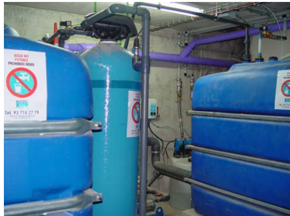
Construcción de un sistema de aprovechamiento de aguas pluviales (izquierda). Sistema de aprovechamiento de aguas grises (derecha).
