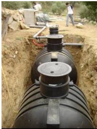
Construcción de un sistema de aprovechamiento de aguas pluviales (izquierda). Sistema de aprovechamiento de aguas grises (derecha).
